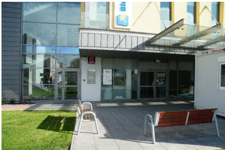
Rysunek 6 Zdjęcie przedstawiające wejście C do budynku
